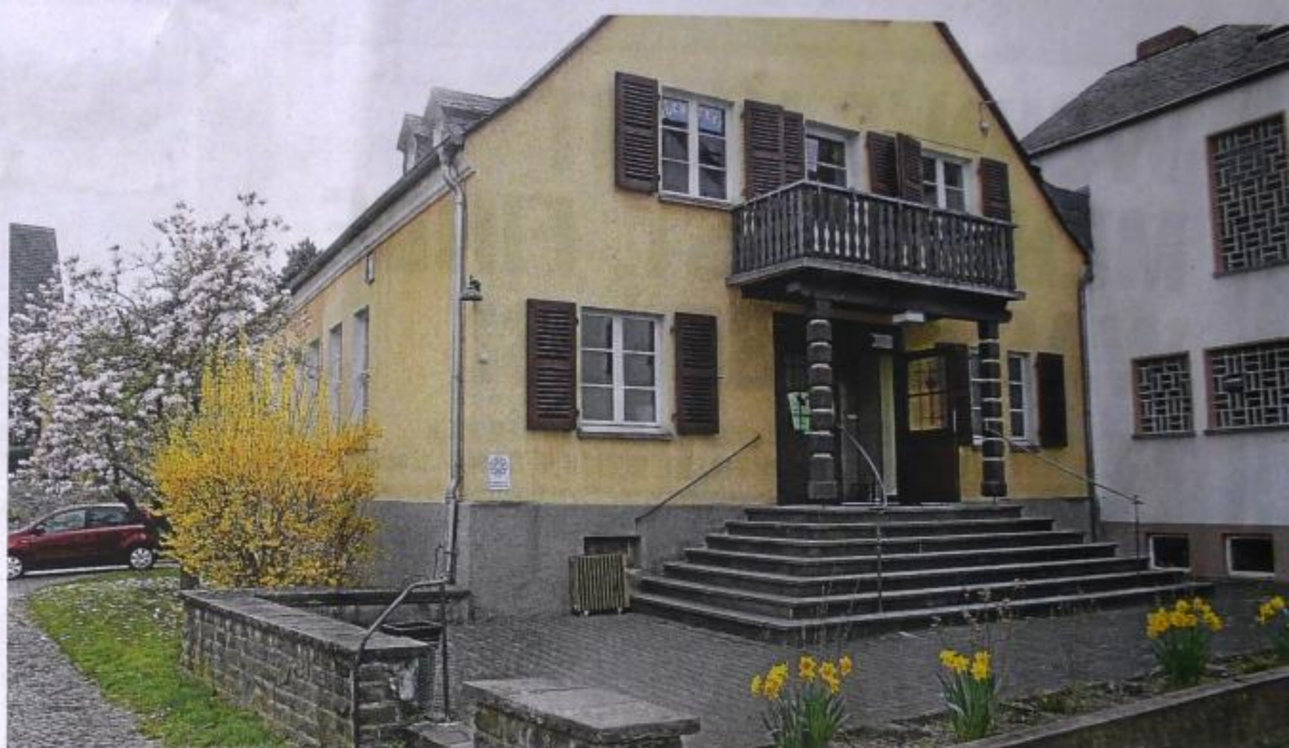
Das evangelische Gemeindehaus in Flacht wird nach der Sanierung aufblühen. Eine von außen erkennbare Veränderung wird ein Treppenlift sein, der gehbehinderten Menschen den Eingang erleichtert. Er führt aus dem Hof auf der linken Seite zur Plattform vor der Eingangstür.
