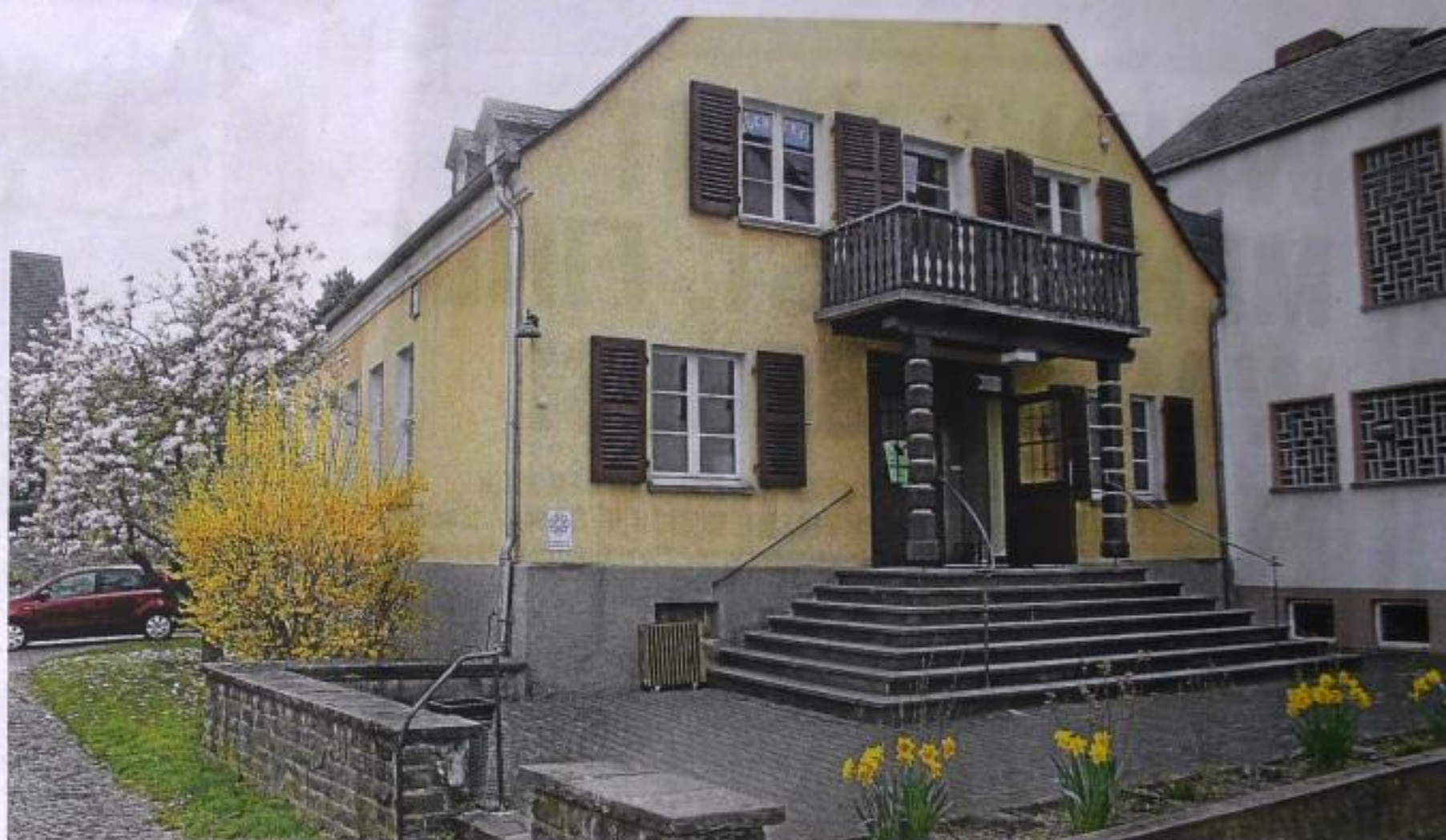
Das evangelische Gemeindehaus in Flacht wird nach der Sanierung aufblühen. Eine von außen erkennbare Veränderung wird ein Treppenlift sein, der gehbehinderten Menschen den Eingang erleichtert. Er führt aus dem Hof auf der linken Seite zur Plattform vor der Eingangstür.
